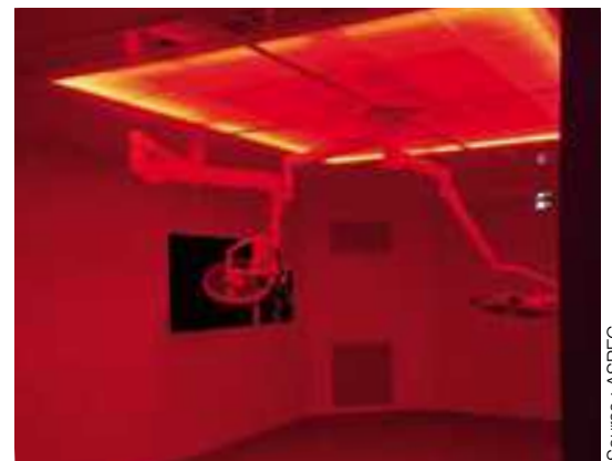
Centrale de traitement d'air en «mode veille» avec un bandeau LED et une bascule en rouge.
